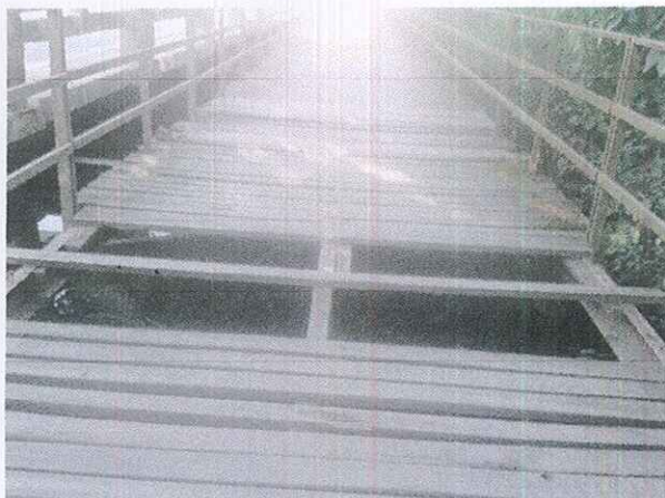
Foto: piso da passarela danificado.
