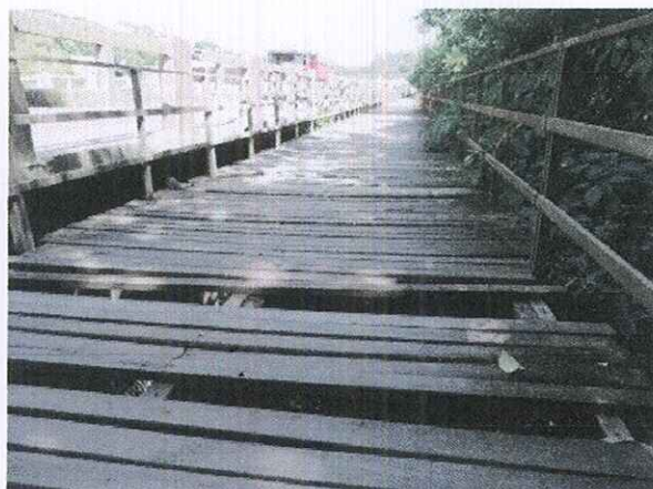
Foto: piso da passarela danificado.
