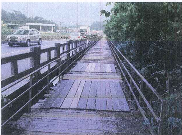
Foto: piso da passarela danificado.
