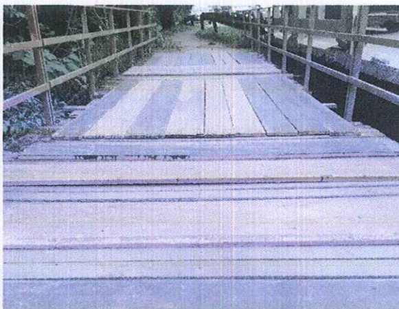
Foto: piso da passarela danificado.
